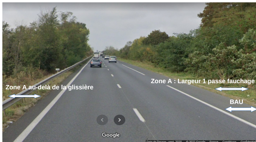
Description des zones A sur la RN 118 au niveau de l'étang de Saclay
