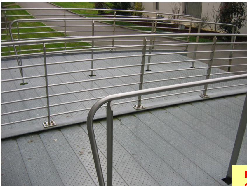
Passerelle bâtiment B
